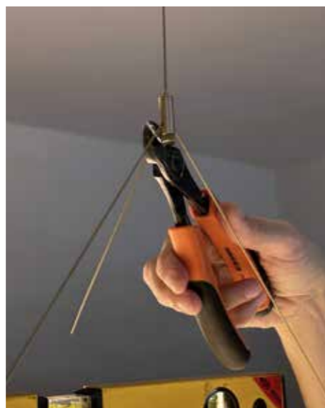
45. Brug en tang eller en solid saks til at afkorte den overskydende wire.
