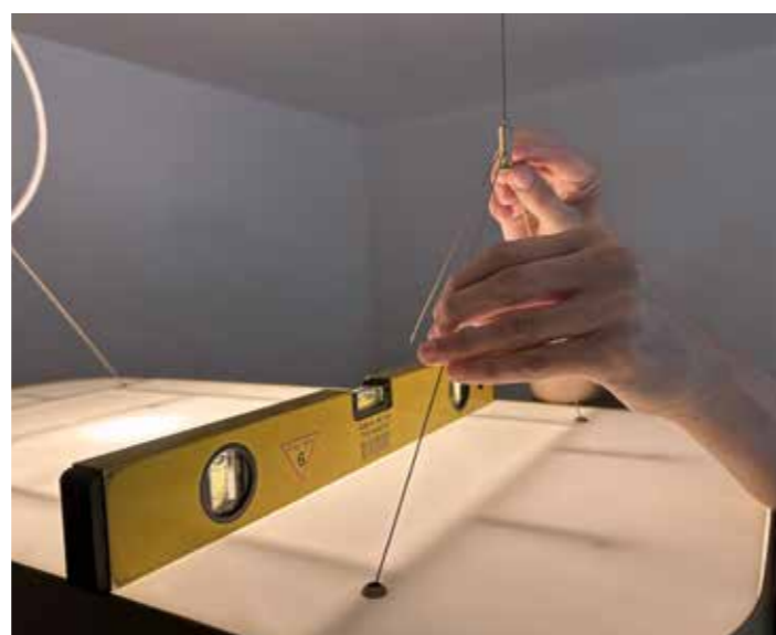
43. Det er stadig muligt at justerer balancen, hvis der er behov for det.
