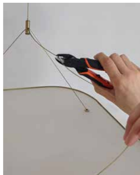
41. Når lampen har den ønskede højde og balance, efterlad en kort længde af ophængswirene (ca. 20 cm) for eventuelle sidste justeringer. Klip det overskydende af med tang eller en solid saks.
