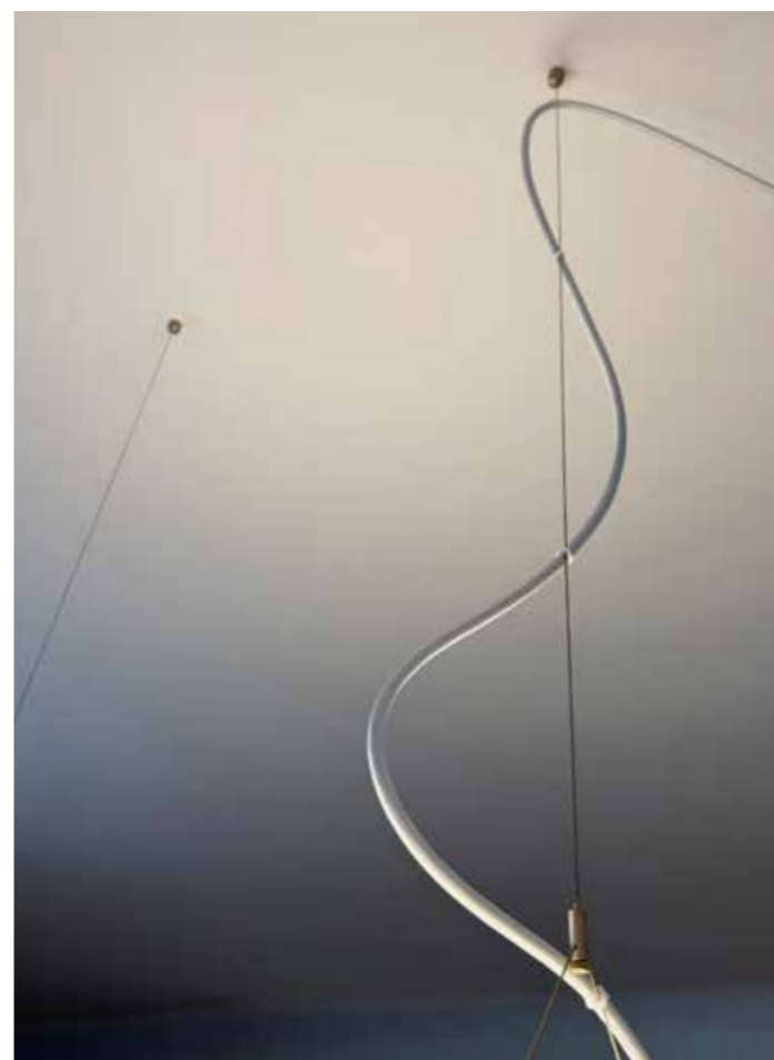
51. Fortsæt med montering af kabelholdere, således at ledningen hænger i en S-formet kurve, som vist.
