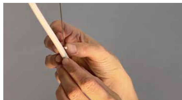
49. Tryk kabelholderen inkl. ledning på plads på wiren.
