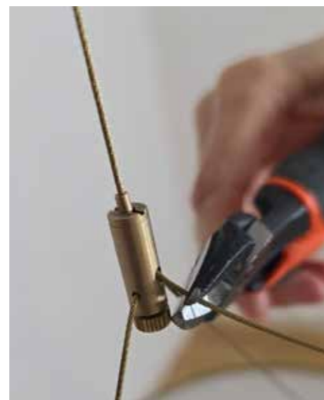
46. Du kan klippe wiren således at der ikke sidder overskydende wire på ophængen.
